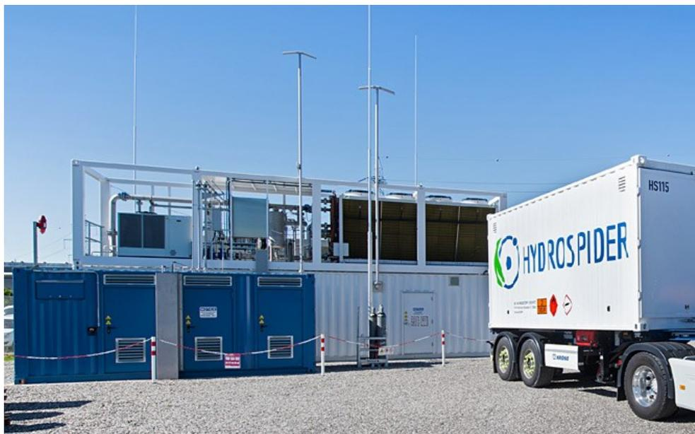
L'installation d'électrolyse produit de l'hydrogène en utilisant l'électricité de la centrale hydroélectrique de Gösgen. Photo: Jean-Luc Grossmann
