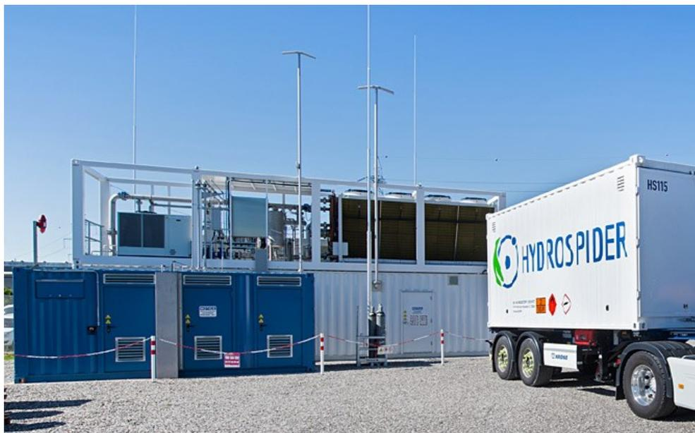
Die Elektrolyseanlage produziert Wasserstoff mit Strom aus dem Wasserkraftwerk Gösgen. Foto: Jean-Luc Grossmann
