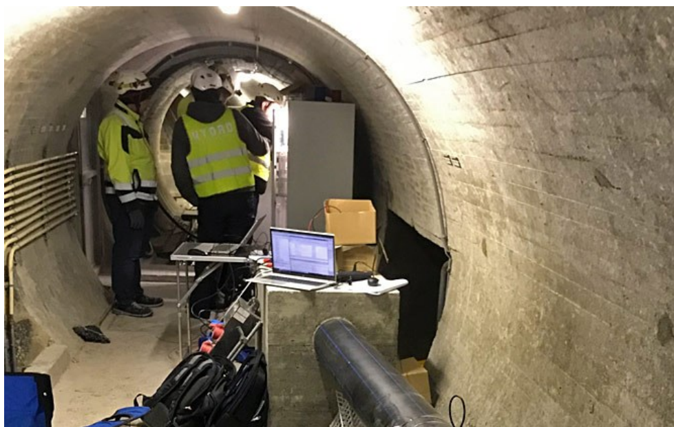
A l'intérieur du barrage de Moiry.
